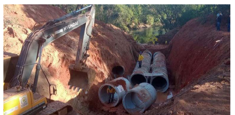
Prefeitura interdita parcialmente trecho da avenida Leste-Oeste, no Bairro Feliz, para realização de obras
